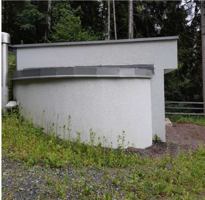
ABBILDUNG 11: PLATZ FÜR TURBINENAUFSTELLUNG IN ENTSÄUERUNGSANLAGE VZ WEST MITTE
